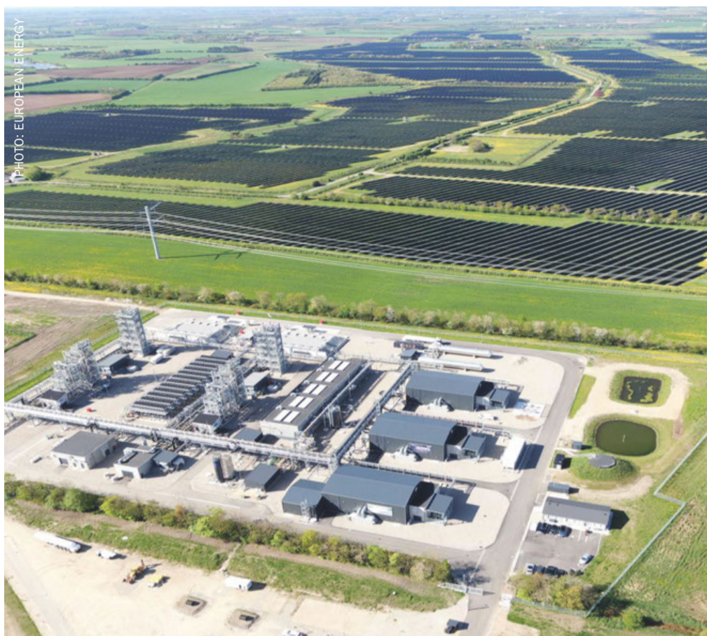
Kassø e-methanol plant.
