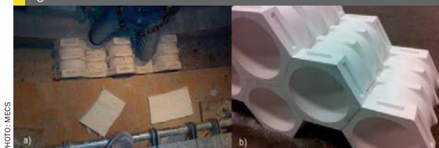
Fig 9: MECS® HexWall™ installation
