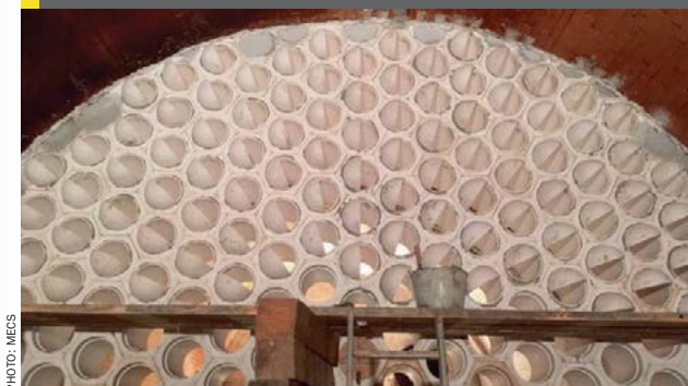
Fig 9: MECS® HexWall™ installation
