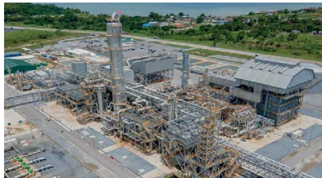
The CGCL site at La Brea, Trinidad.
