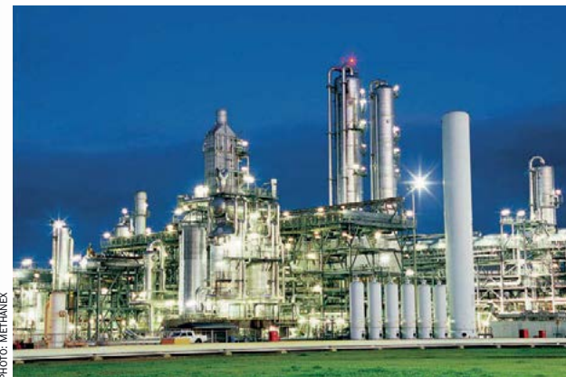
Methanex plant, Trinidad.
